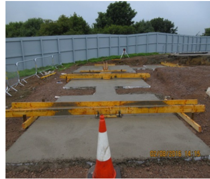
15c Pad foundations after concrete pour
