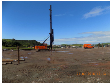
16a Piling Rig
